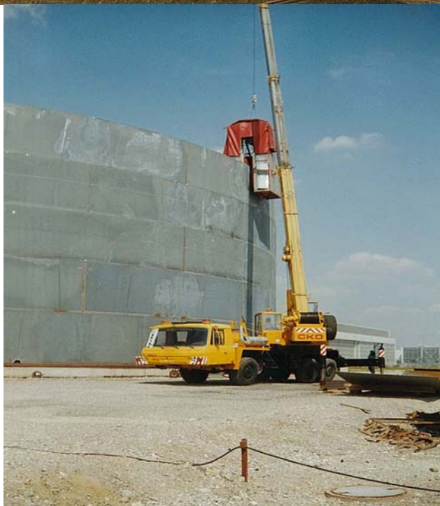
Корпусные стенки резервуаров, подготовленные для автоматической сварки при монтаже
